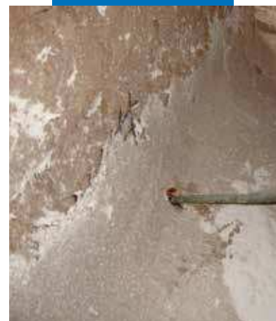
Inserimento di MapeWrap FIOCCO nel foro
