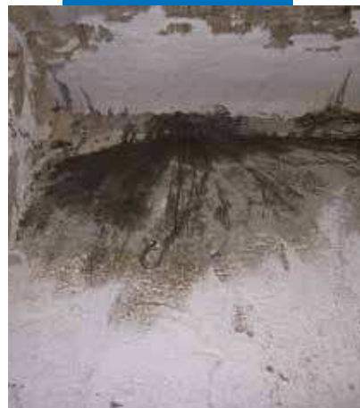
Connessione puntuale realizzata mediante MapeWrap B FIOCCO
