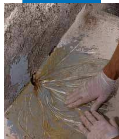
Apertura a ventaglio di MapeWrap FIOCCO
