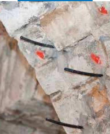
Particolare del fissaggio dei tubicini di iniezione
