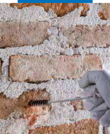
Asportazione delle polveri dai fori
