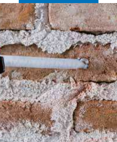
Applicazione di fissaggio chimico
