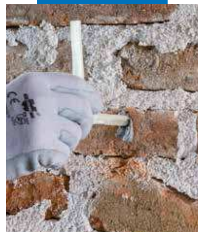
Posa di Mape-net EM Connector
