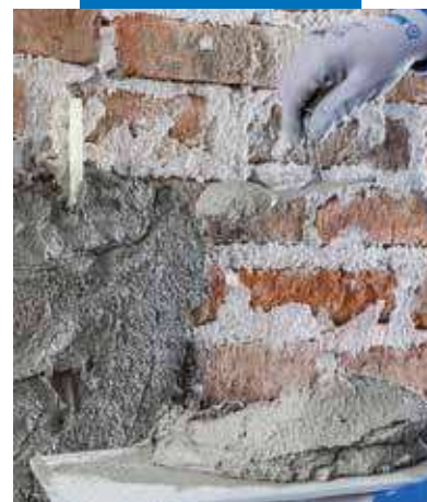
Applicazione del primo strato di Planitop SR
