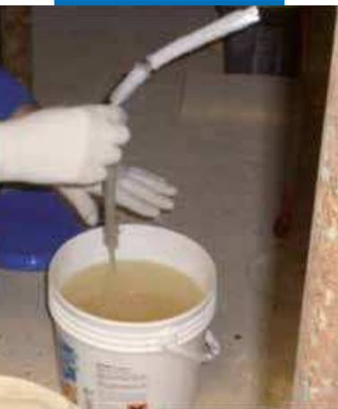
Impregnazione di una porzione di MapeWrap FIOCCO
