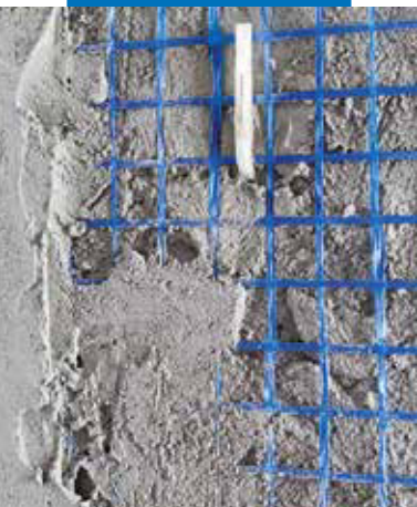
Applicazione del secondo strato di Planitop SR
