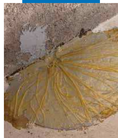
Impregnazione di MapeWrap FIOCCO
